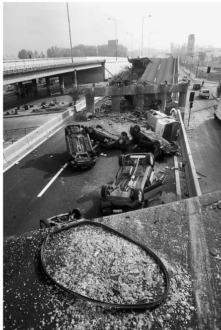
Eine geborstene Brücke riss mehrere Autofahrer in den Tod. Foto: Reuters
